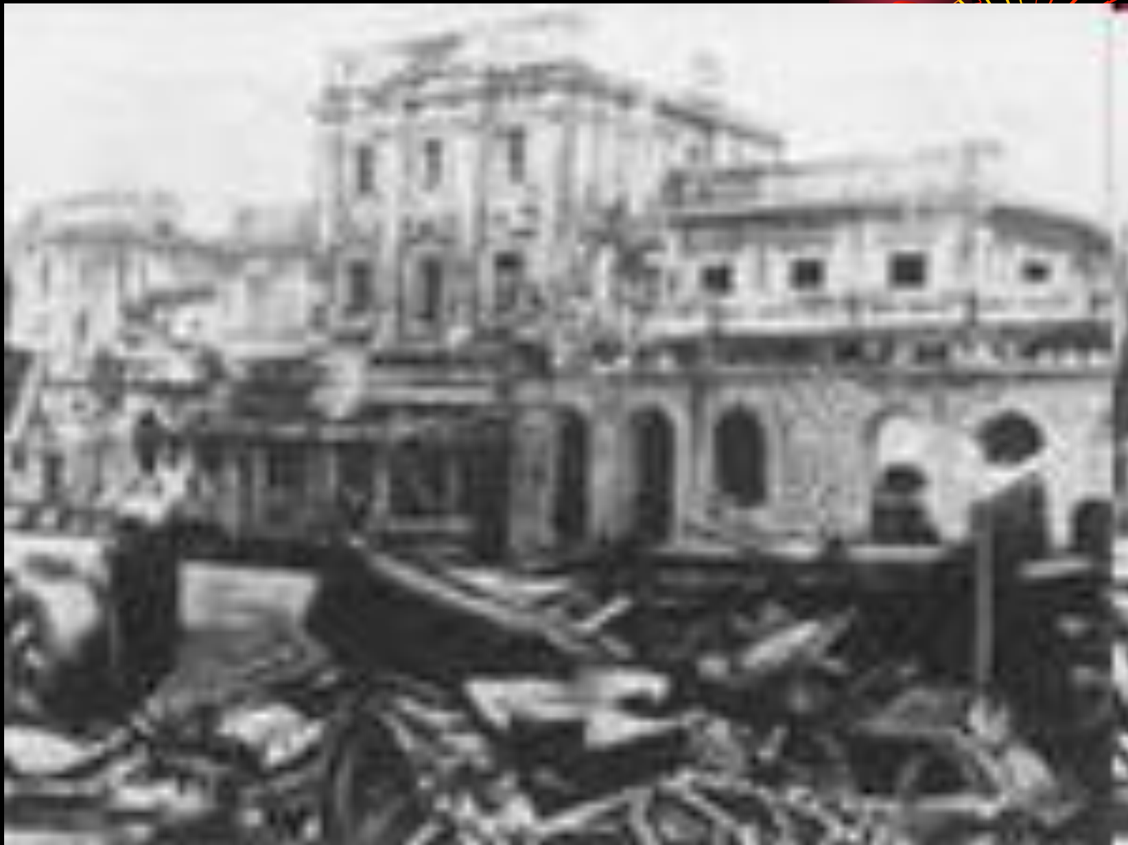
Разрушенный после оккупации Ростов
