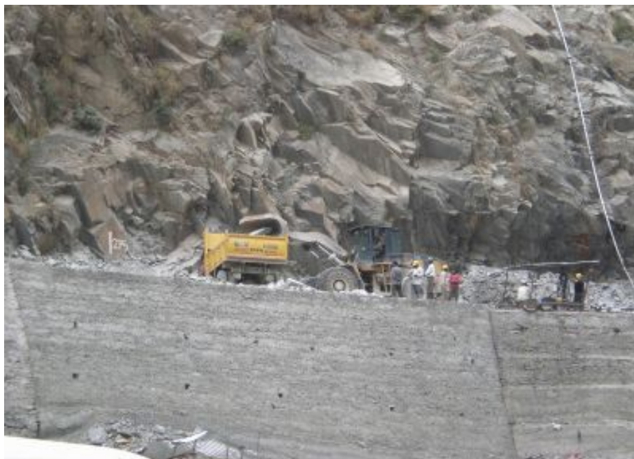
Гидроэлектрическая дамба в Химчал, Индия. Высота – 3000 м над уровнем моря
