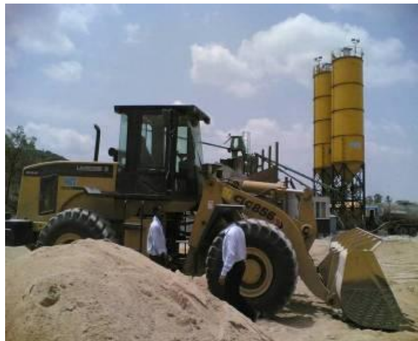
Строительство объездной дороги в Ченнаи
