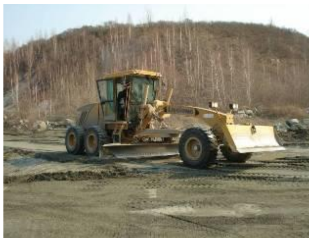
Автогрейдер CLG418 на ремонте дороги.
