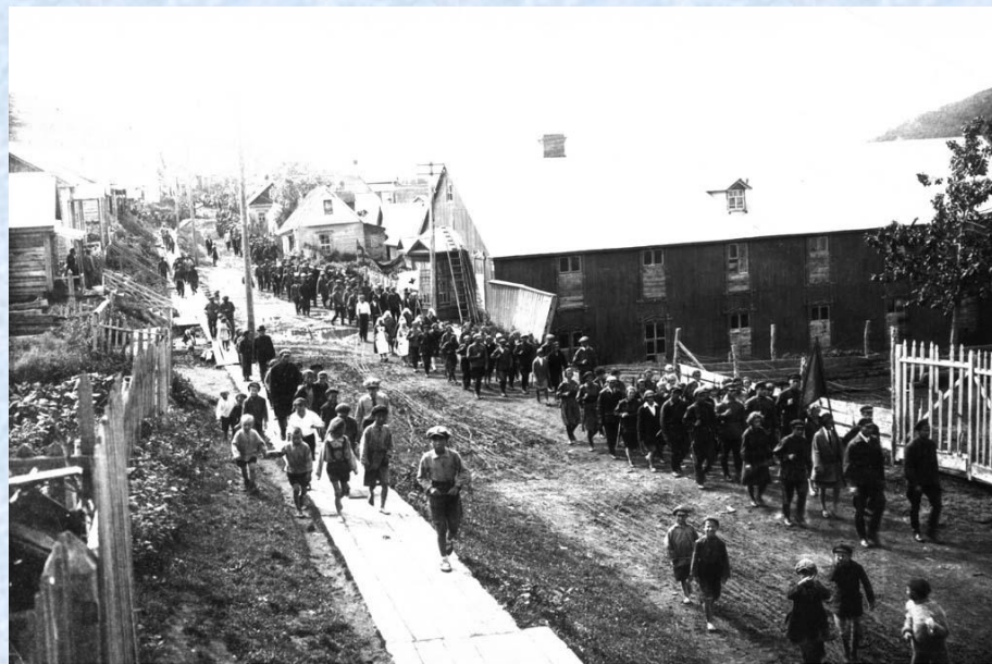
1926 г. 8 июля. Демонстрация по поводу юбилея Камчатского комсомола, ул. Ленинская
