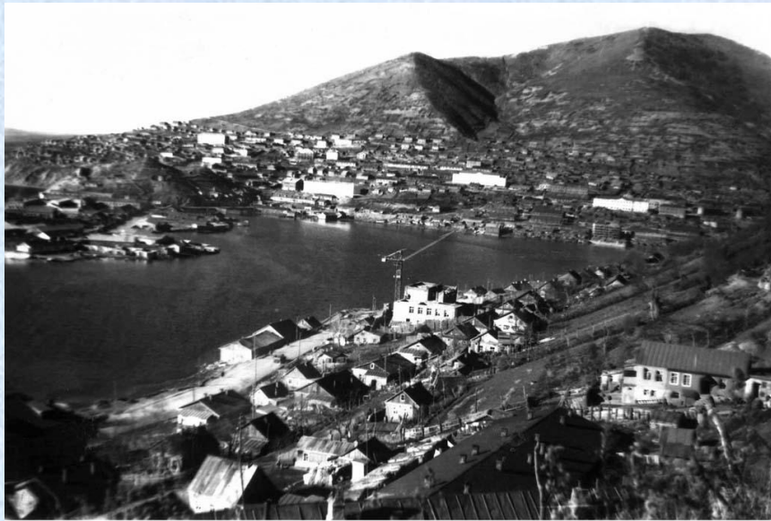
1956-57 гг. Строительство первого здания для пединститута. (Современное здание - ул. Набережная, 26)
