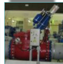
Установка арматуры для удаления воздуха и предотвращения гидроудара
