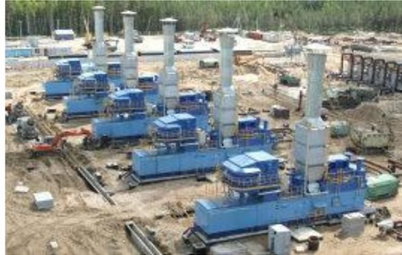
ГПА-4РМ - автоматизированный газоперекачивающий агрегат блочно-контейнерного исполнения номинальной мощностью 4 МВт предназначен для использования на станциях подземного хранения газа (СПХГ) и перекачки газа по трубопроводам. В качестве привода нагнетателя используется газотурбинный двигатель ГТД-4РМ мощностью 4 МВт, разработанный на базе газотурбинного двигателя судового применения М-75Р.
