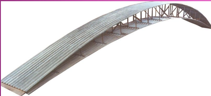
Пространственная система двухпоясного арочного покрытия с совмещением в стальных профилированных листах
