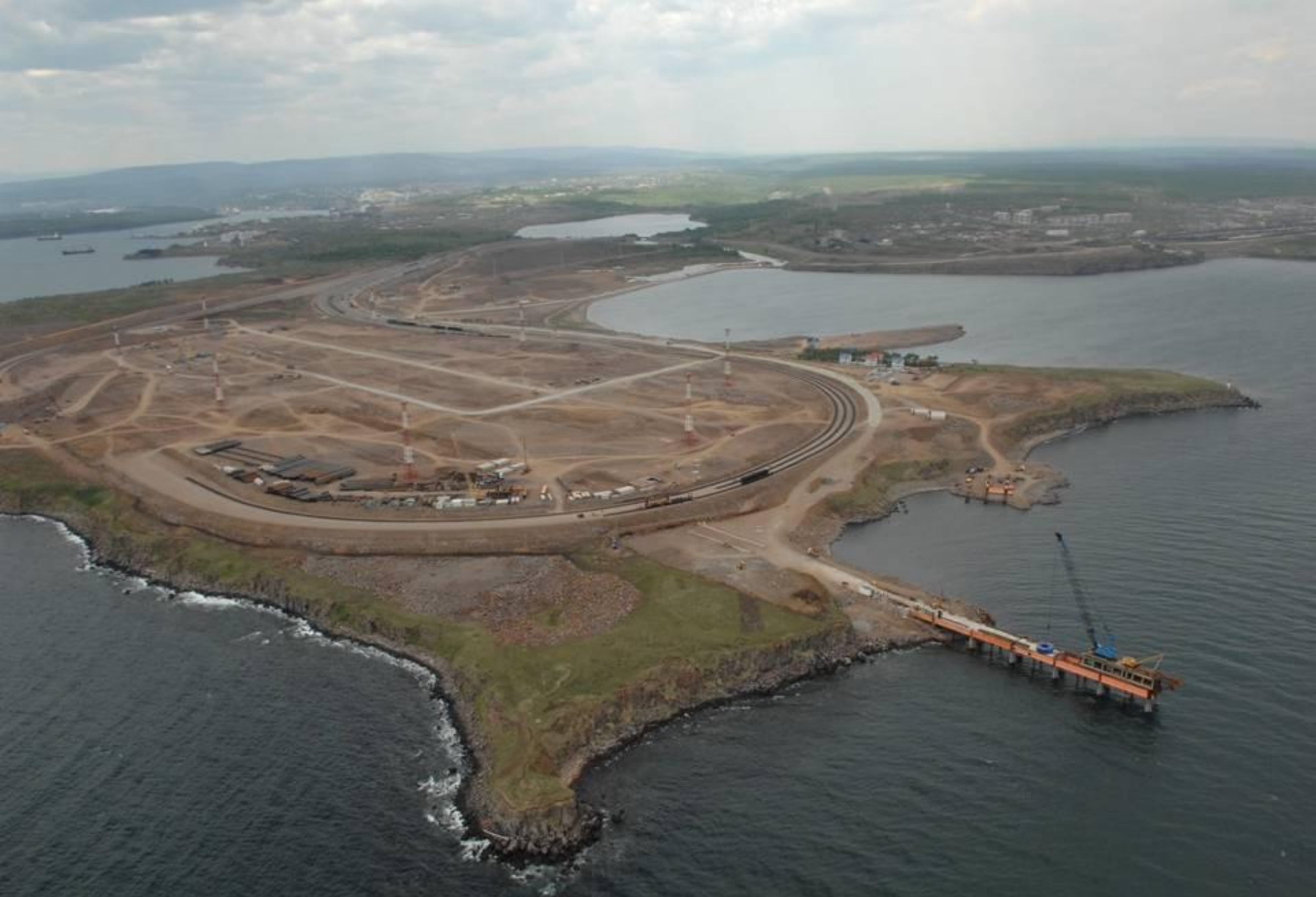
Строительство угольного терминала
