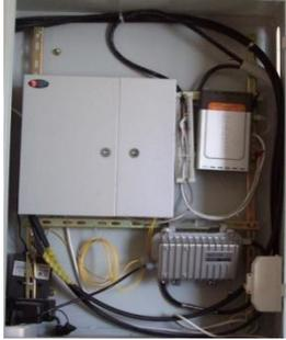
Оптимальное размещение оборудования в ДШ-1 в случае использования коммутатора больших или малых размеров.
