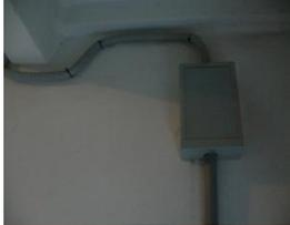
При нарушении соосности отверстия и трубы ПНД применяется гофрированная труба.
