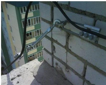
**Надежное крепление к парапету, между кабелем и конструкциями здания выдержан интервал, крепление SO-65 и талрепа к рамгайке правильное.**
