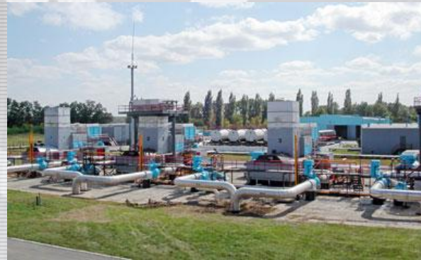
Трассами магистрального газопровода
