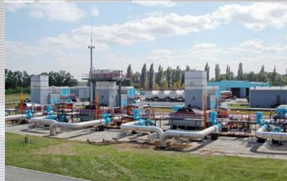
Трассами магистрального газопровода
