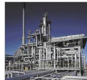
Установка изомеризации на зарубежном НПЗ. Площадка: **75 м × 50 м**
