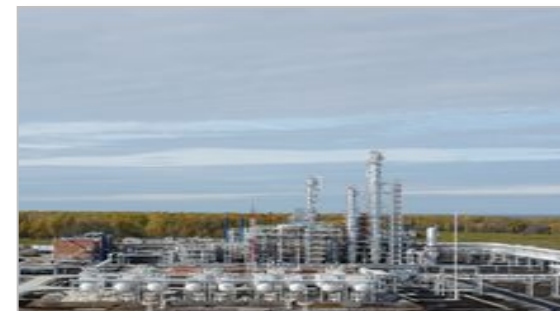
Установка изомеризации на российском НПЗ. Площадка: 150 м × 300 м
