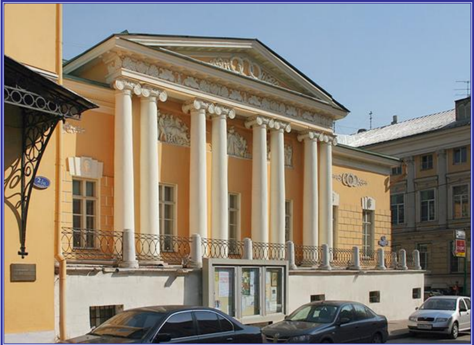
Фасад со стороны Хрущевского переуллка
