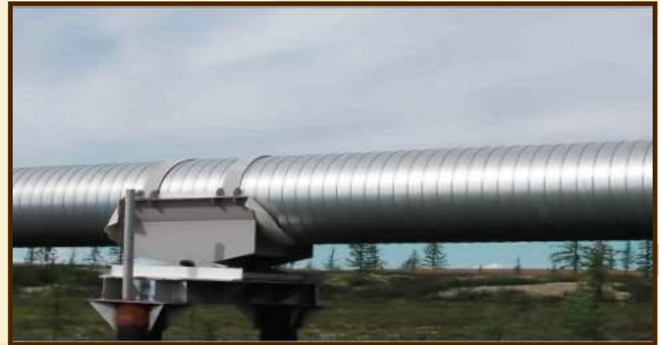
Трубопровод Ванкор – Пурпе, 556 км
