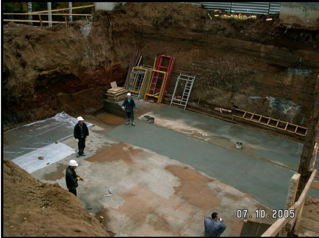
Материалы «Гидротэкс» производятся на основе минерального вяжущего вещества и могут подвергаться механическим нагрузкам уже через двадцать четыре часа (сутки) после нанесения на поверхность защищаемой конструкции.
