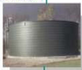
РЕЗЕРВУАР ДЛЯ ХРАНЕНИЯ ОРГАНИКИ
