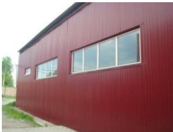
Здание мойки, с боку
