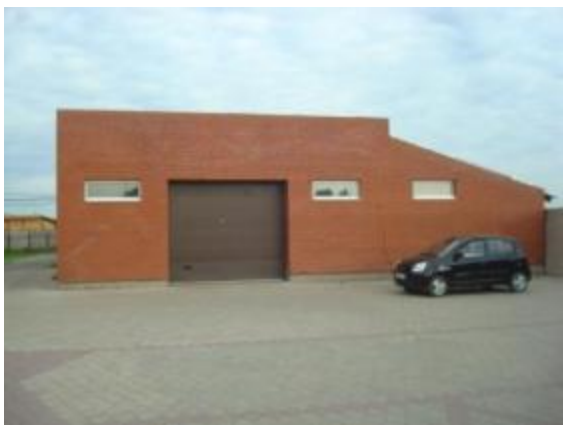
Здание мойки со стороны въезда
