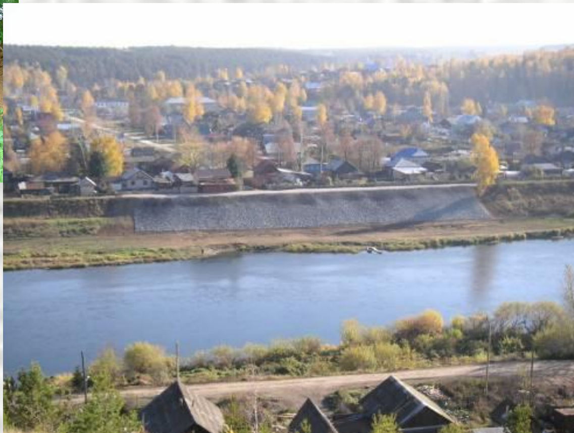
Участок дамбы на р.Сылва по ул.Хмелева, д. 114, г.Кунгур (до и после капитального ремонта)
