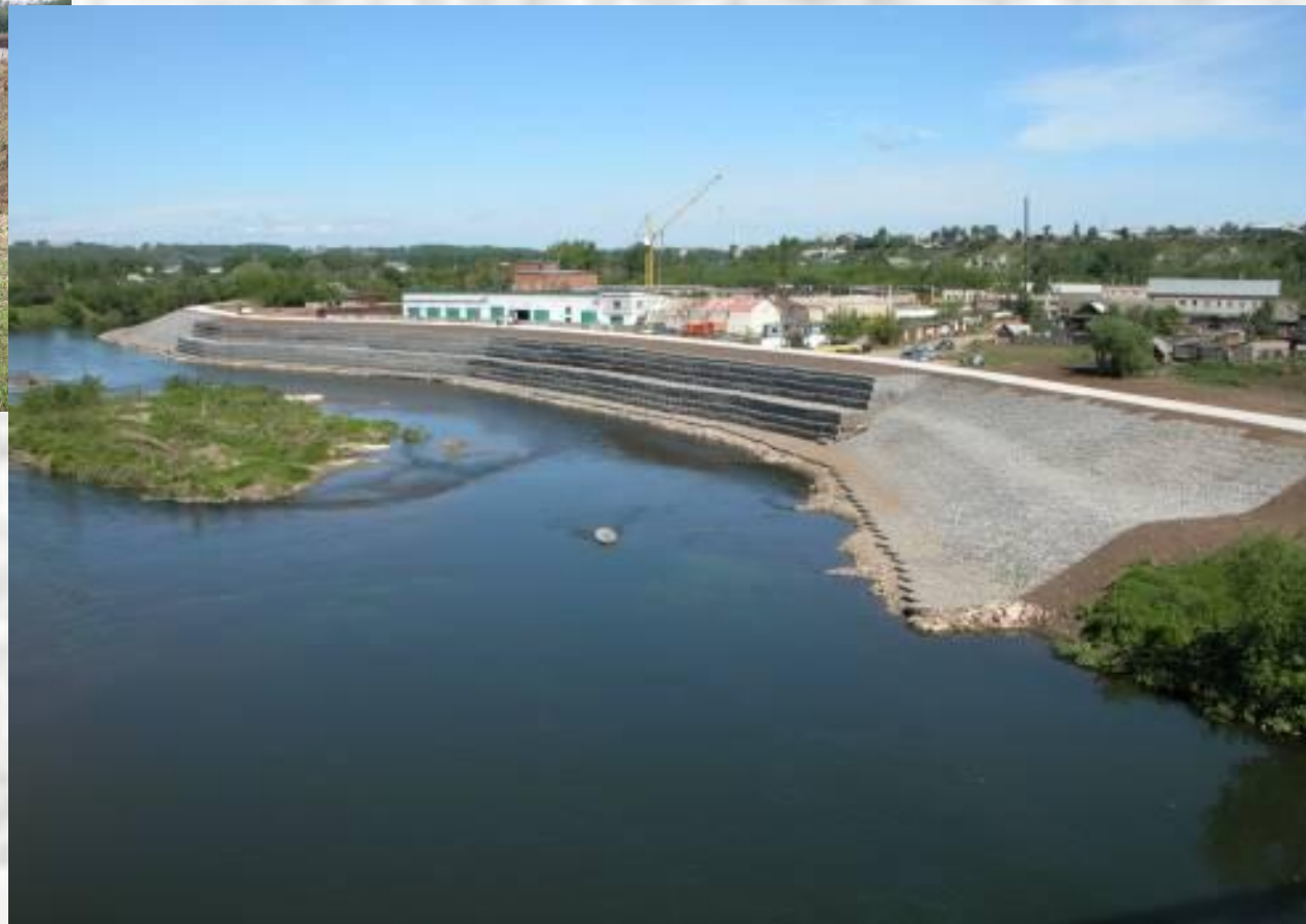
Реконструкция дамбы на правом берегу р.Ирень от ж/д моста до ул.Спортивная в г.Кунгуре (до и после реконструкции)
