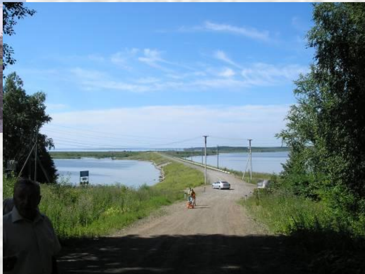
Восстановленная плотина Чермозского пруда (до и после строительства)
