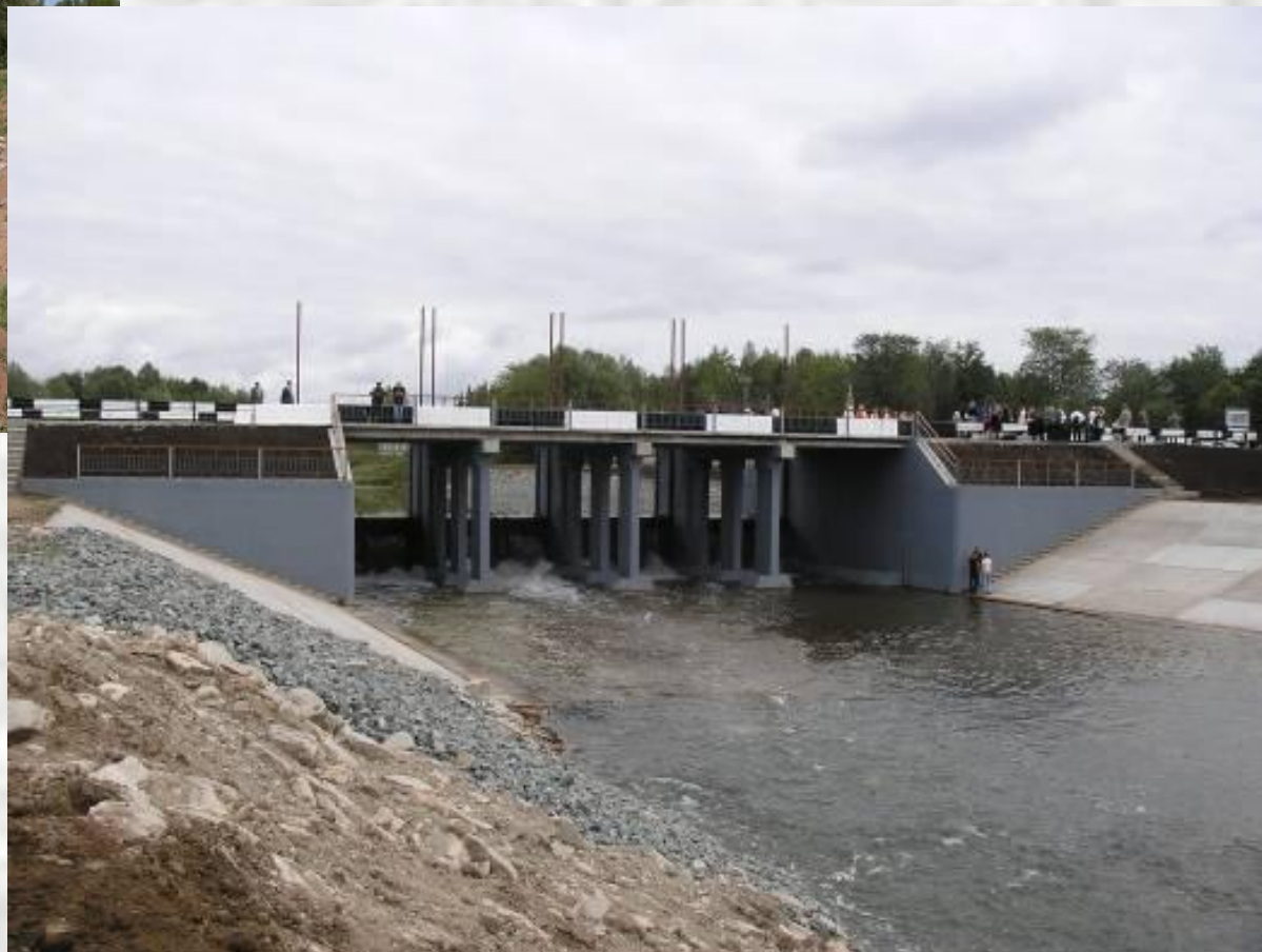
Реконструкция плотины на р.Быстрый Танып в г.Чернушка (до и после реконструкции)
