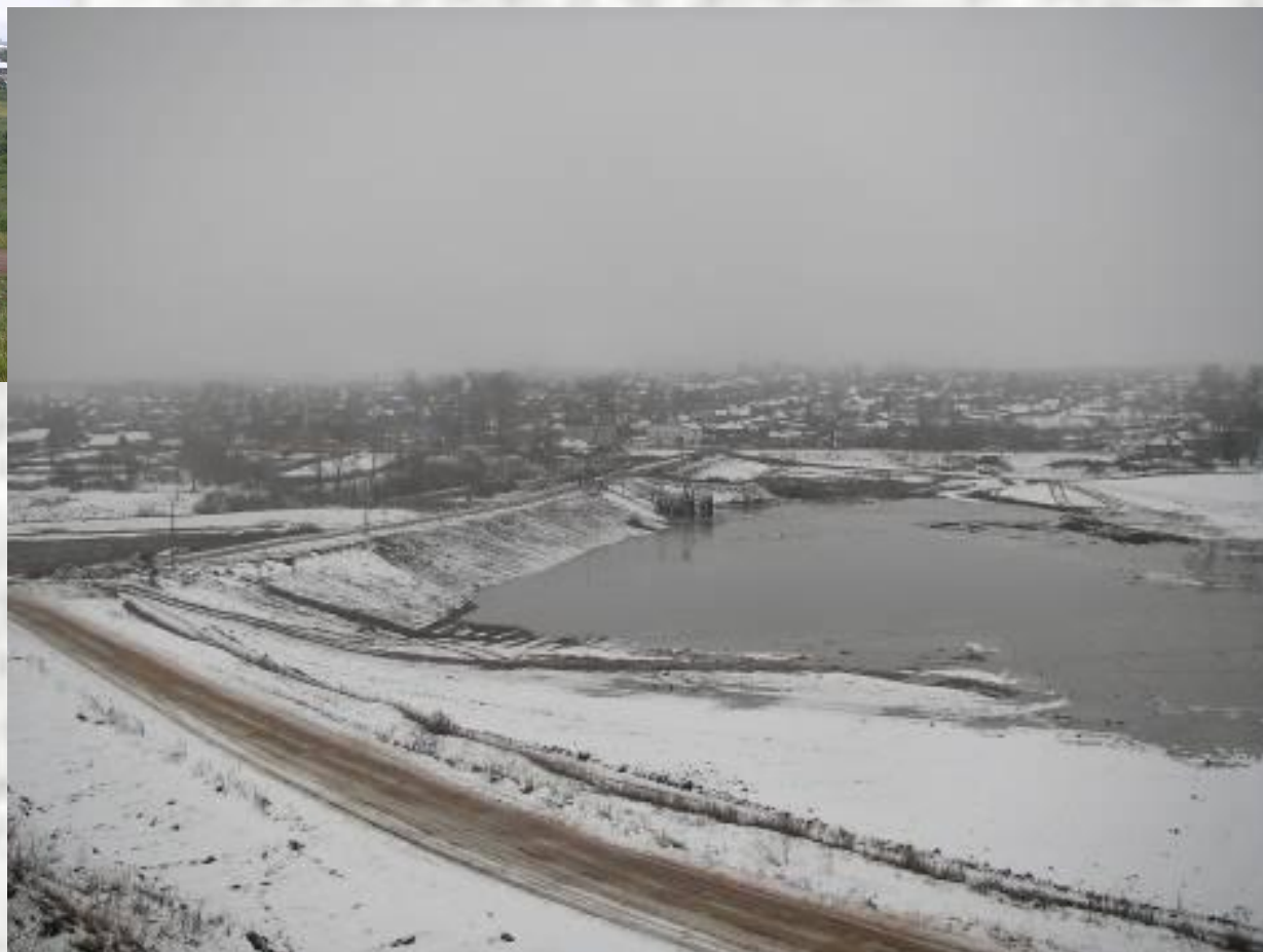
Восстановление пруда в п.Юг Пермского района (до и после реконструкции ГТС)
