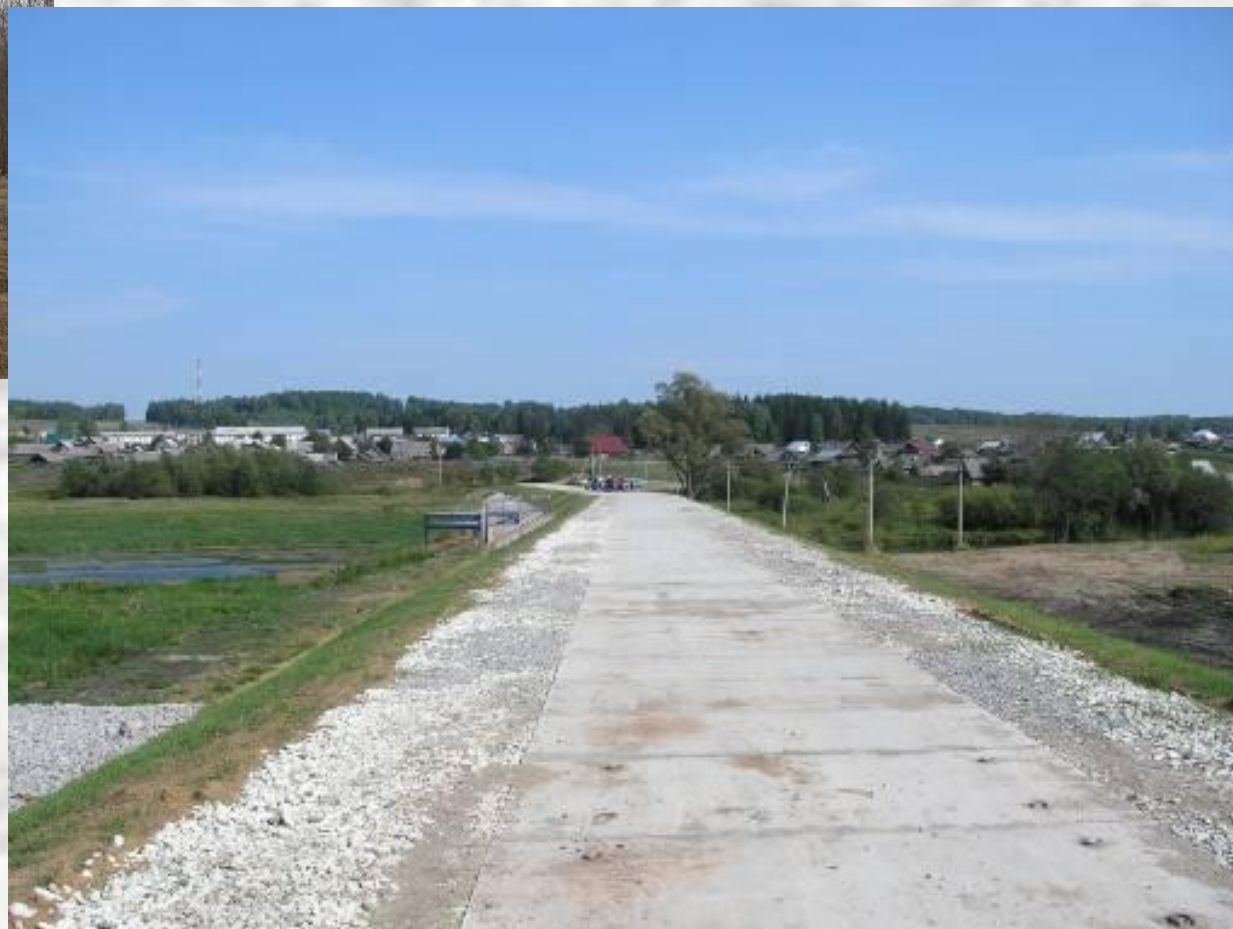
ГТС пруда на р.Поша в с. Уральское Чайковского района (до и после капитального ремонта)
