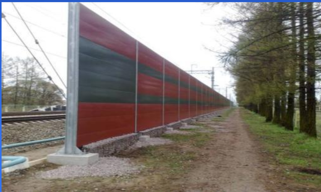
Установка шумозащитного экрана на станции Саблино Октябрьской железной дороги
