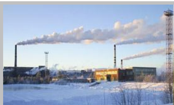
Общестроительные и кровельные работы на Ковдорском ГОК Мурманская область, 2003 г
