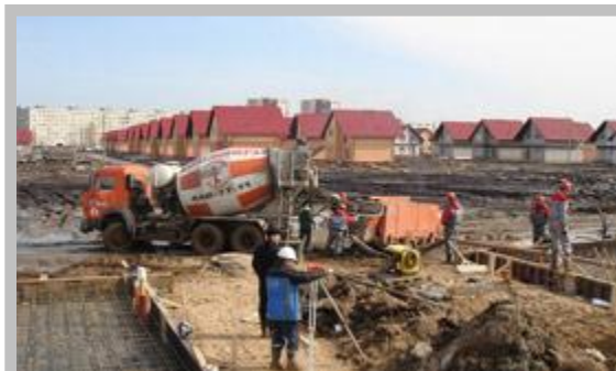
Работы по строительству и устройству инженерных сетей коттеджной застройки «Новая Ижора», г. Санкт-Петербург 2008г.
