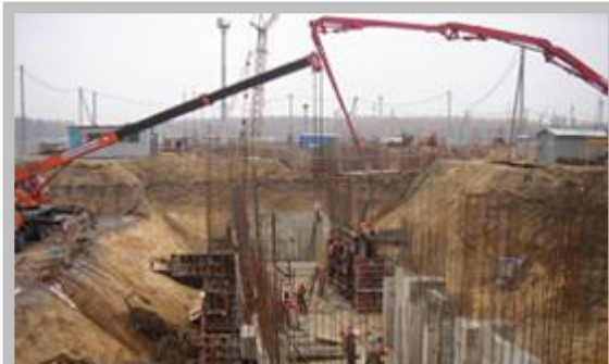
Участие в строительстве новой доменной печи № 7. Строительство ДП №7 на объекте «Новолипецкого металлургического комбината»
