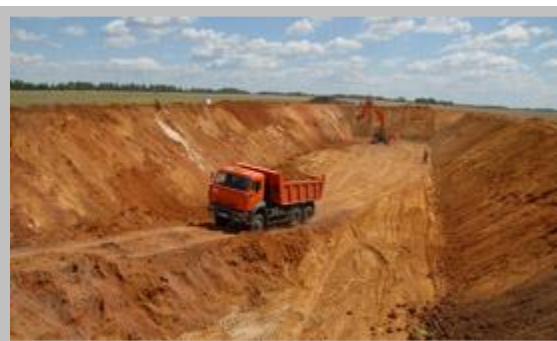
ОАО «Липецкмясопром», входящего в группу компаний «Черкизово» (Липецкая область)
