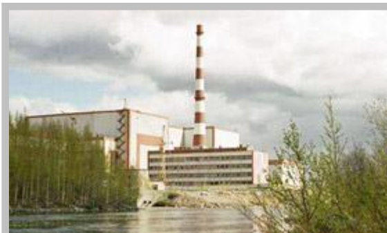
ГП «Кольская атомная электростанция» (Мурманская область)
