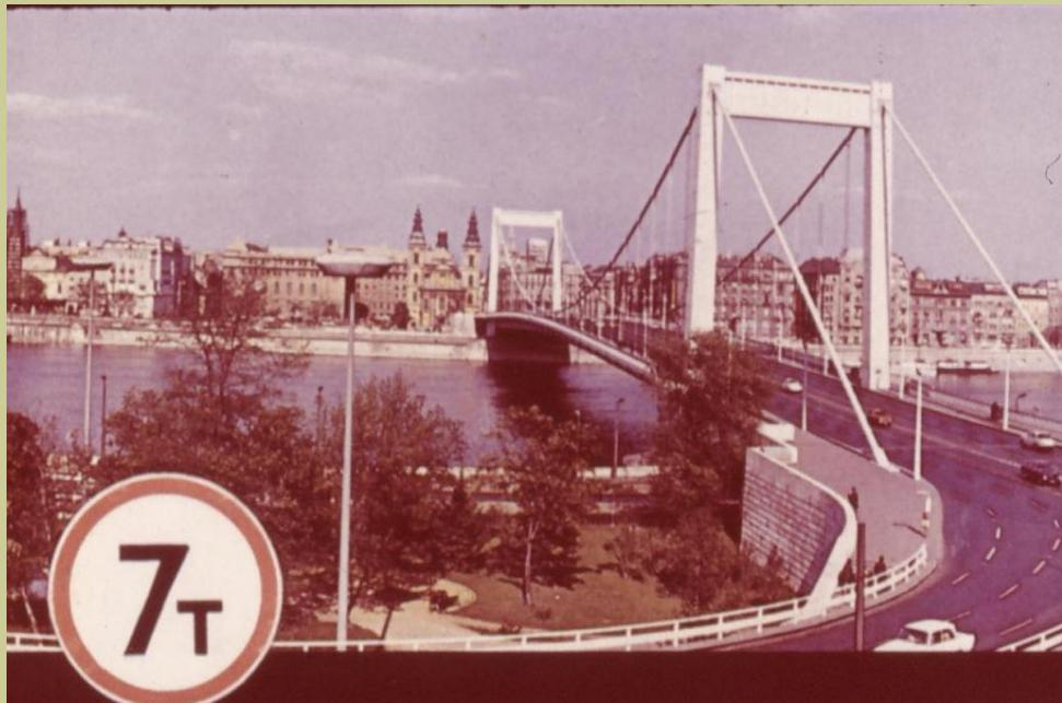
Такой знак при въезде на мост означает, что максимальный вес транспортной единицы с грузом не должен быть больше 7 тонн ( $70\ 000\text{Н}$ ), чтобы не превысить допустимую силу давления на опоры моста.
