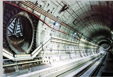
Тоннель под Ламаншем
