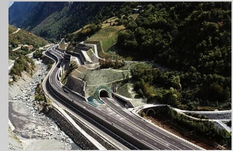
Тоннели Автодороги (A43, A87, A89,...)
