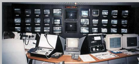
Системы и оборудование Перемещение и дорожный транспорт на Иль де Франс
