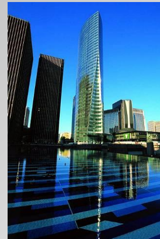
Сектор обслуживания Башня EDF (PB6) в деловом квартале Дефанс
