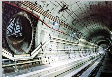
Тоннель под Ламаншем
