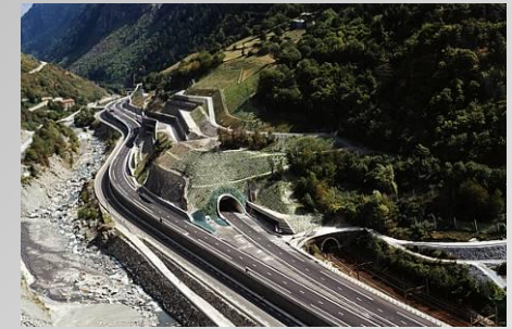
Тоннели Автодороги (A43, A87, A89,...)
