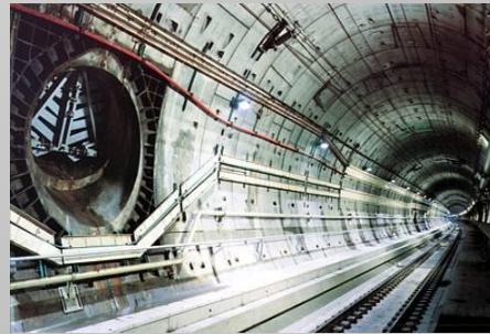
Тоннель под Ламаншем
