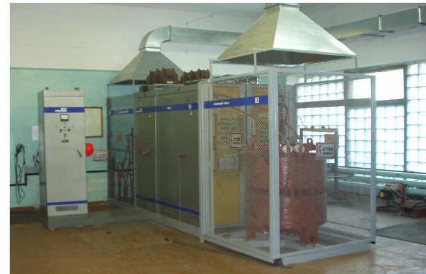
Тиристорный преобразователь частоты ПЧ–ТПП–200–10к– УХЛ4 Центральная насосная станция, г. Москва
