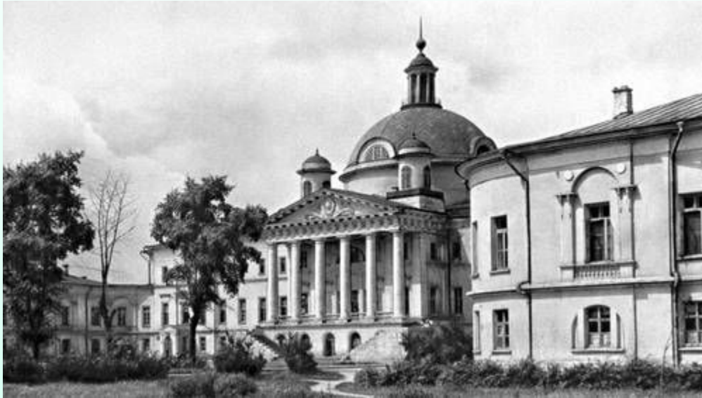
Голицынская (ныне 1-я городская) больница в Москве. 1796—1801. Архитектор М. Ф. Казиков.
