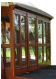
Образовавшийся тамбур препятствует попаданию холода в помещение при открывании дверей. В качестве дополнительной защиты рекомендуется установка тепловой завесы.
