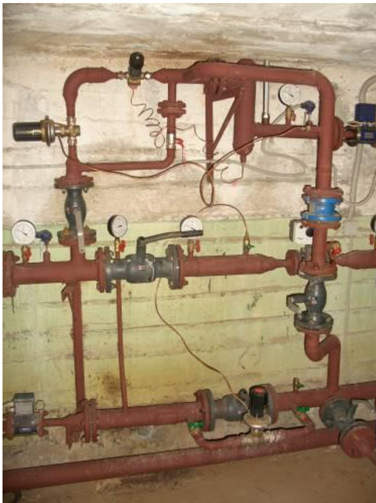
АУУ с насосным смешением теплоносителя
