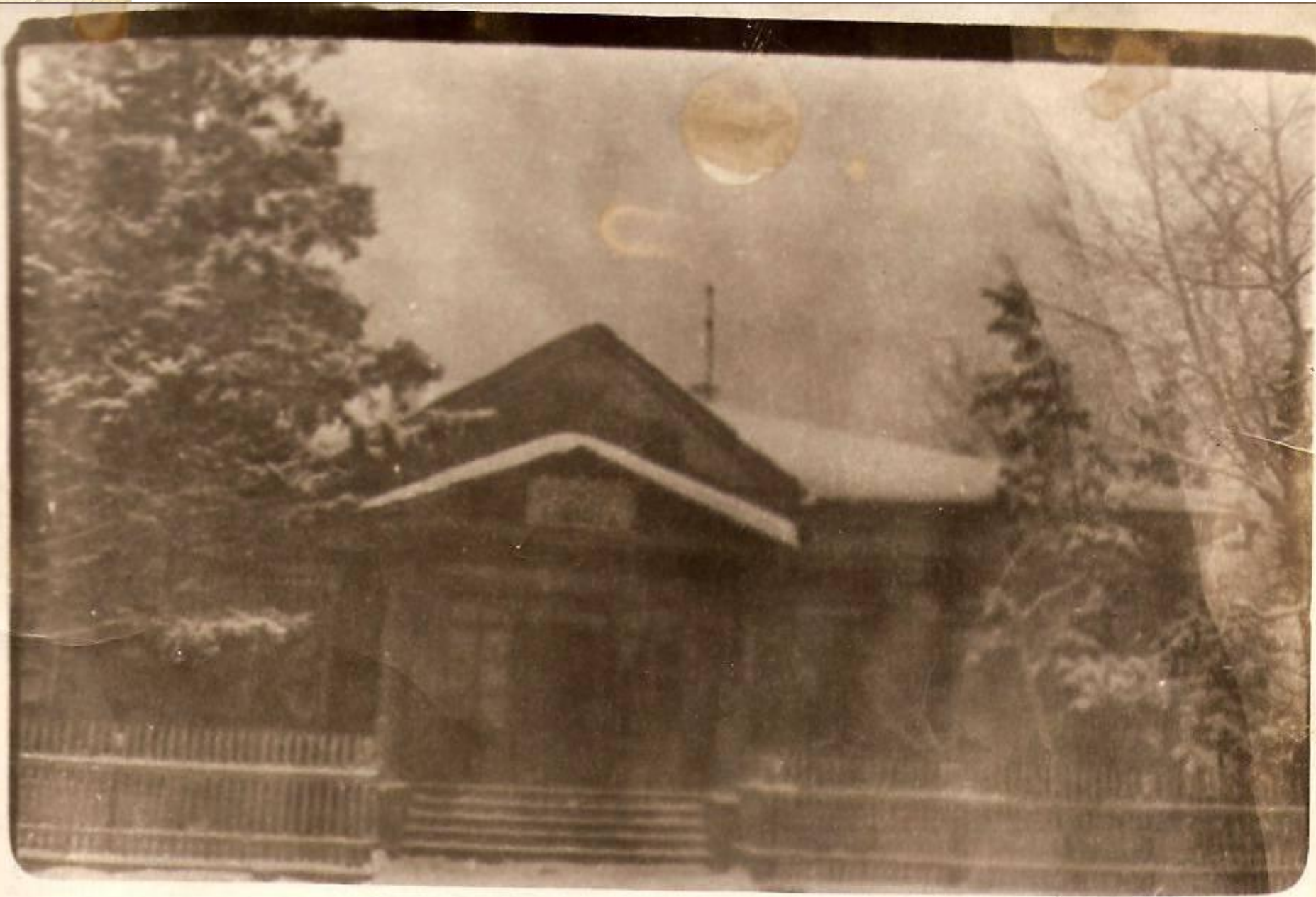
Здание Старо-Зиминской школы №9
