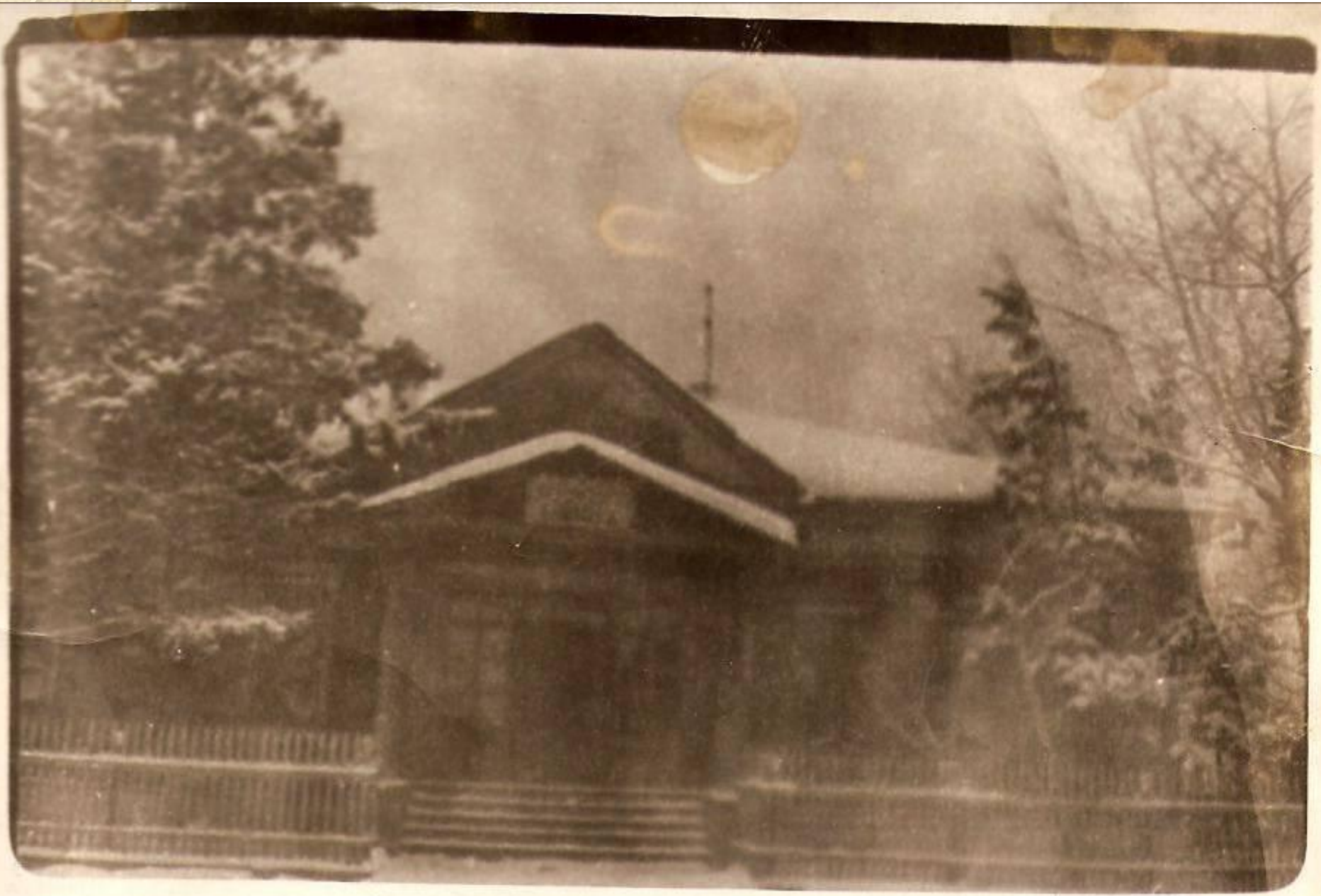
Здание Старо-Зиминской школы №9
