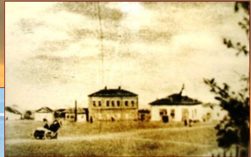
Село Землянки (Алексеевка)
