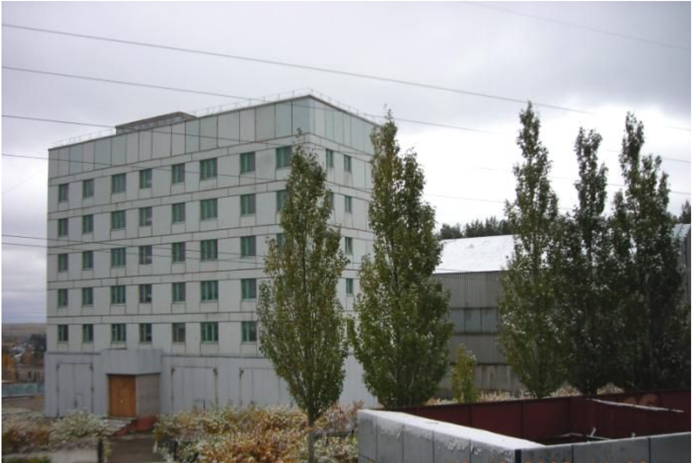
внешний вид административного здания
