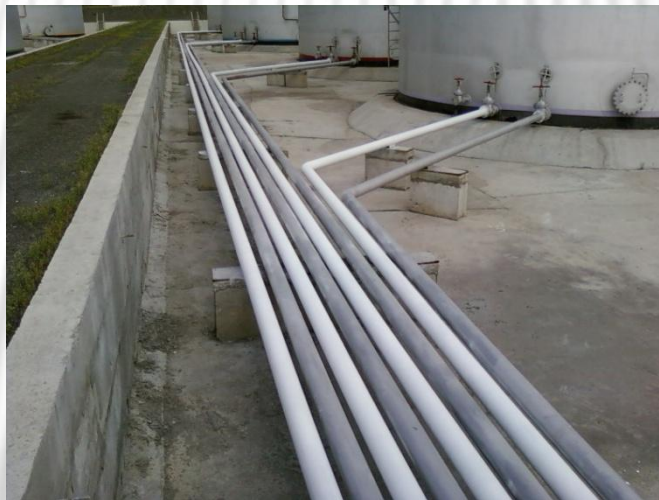
Утепление емкостей воды и нефтепродуктов
