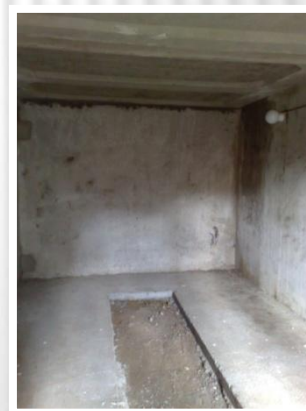
г. Красноярск- утепление гаража
