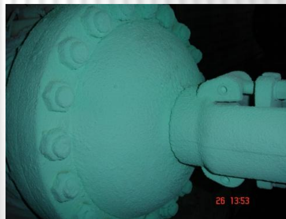
г. Красноярск, ЭВРЗ - утепление трубопроводов и оборудования
