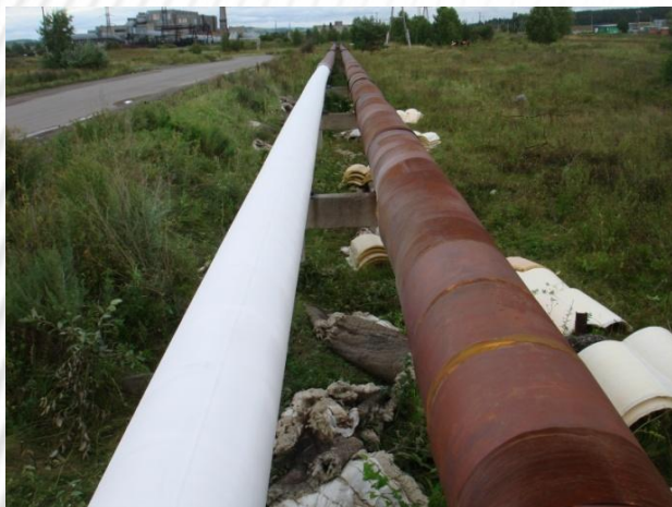
г. Красноярск, «Красмаш» - утепление теплотрассы
