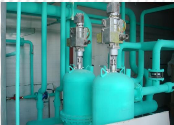
г. Красноярск, Аэропорт - утепление трубопроводов и оборудования
