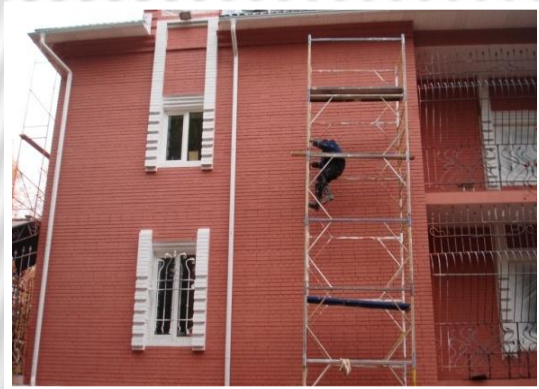
г. Красноярск, п. Горный -Утепление фасада коттеджа
