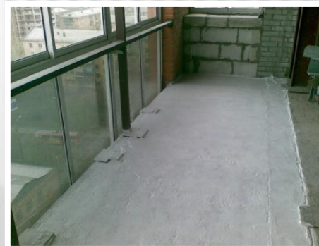
г. Красноярск, квартира пр. Свободный - утепление пола
