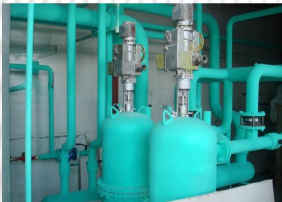
г. Красноярск, Аэропорт - утепление трубопроводов и оборудования
