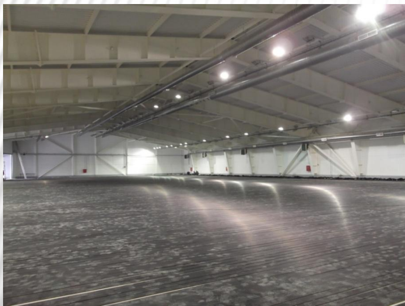
г.Красноярск, утепление катка с внутренней стороны
