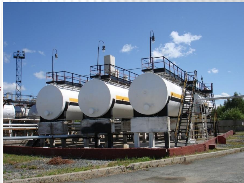
г.Ачинск, «РОСНЕФТЬ» Утепление емкостей хранения ГСМ
