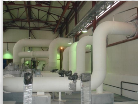
г. Красноярск ПНС Северный - утепление трубопроводов и оборудования
