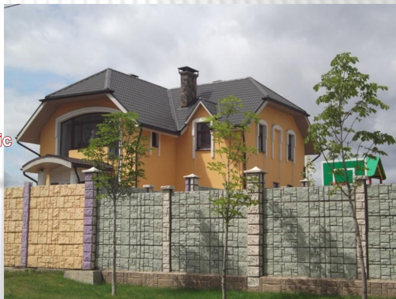
г.Красноярск, Утепление Коттеджа
