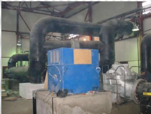
г. Красноярск, «Красмаш» - утепление теплотрассы
