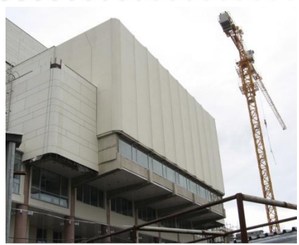
г. Красноярск - утепление фасада Большого Концертного Зала
