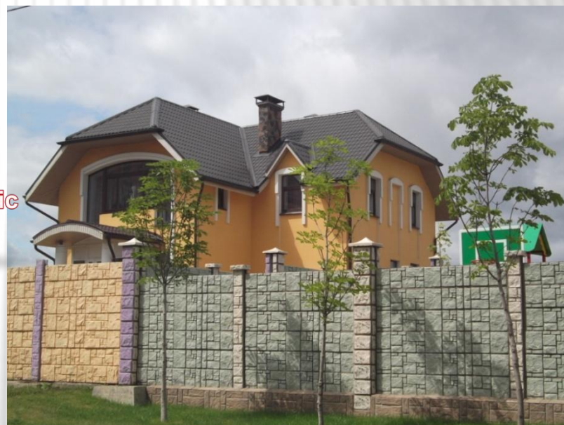
г.Красноярск, Утепление Коттеджа
