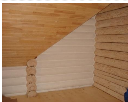
г. Красноярск п. Сосны - утепление деревянных стен
