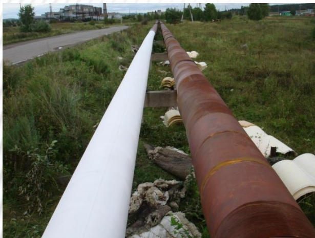
г. Красноярск, «Красмаш» - утепление теплотрассы
