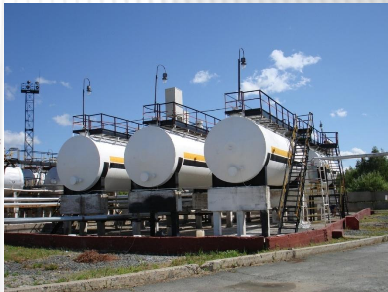
г.Ачинск, «РОСНЕФТЬ» Утепление емкостей хранения ГСМ
