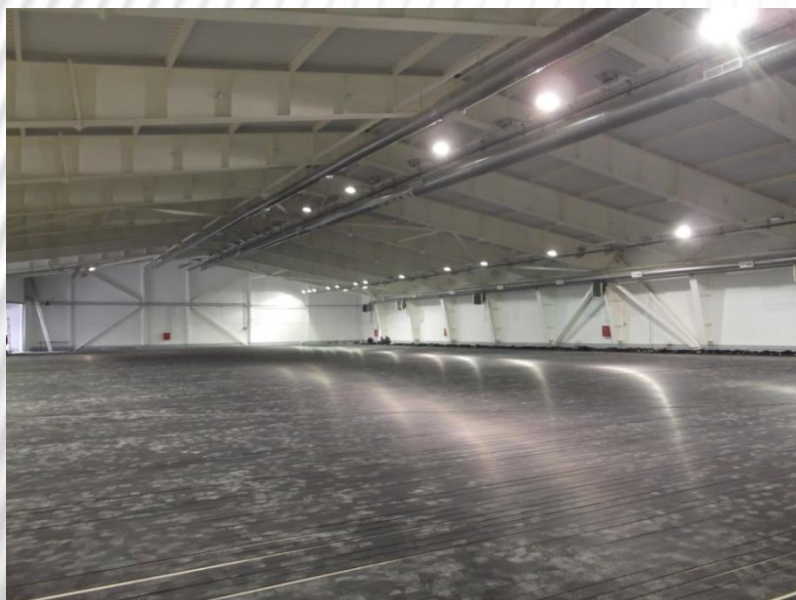
г.Красноярск, утепление катка с внутренней стороны
