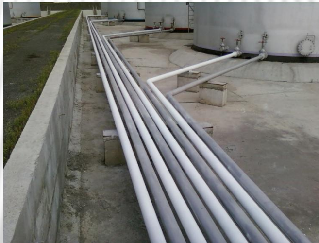
Утепление емкостей воды и нефтепродуктов
