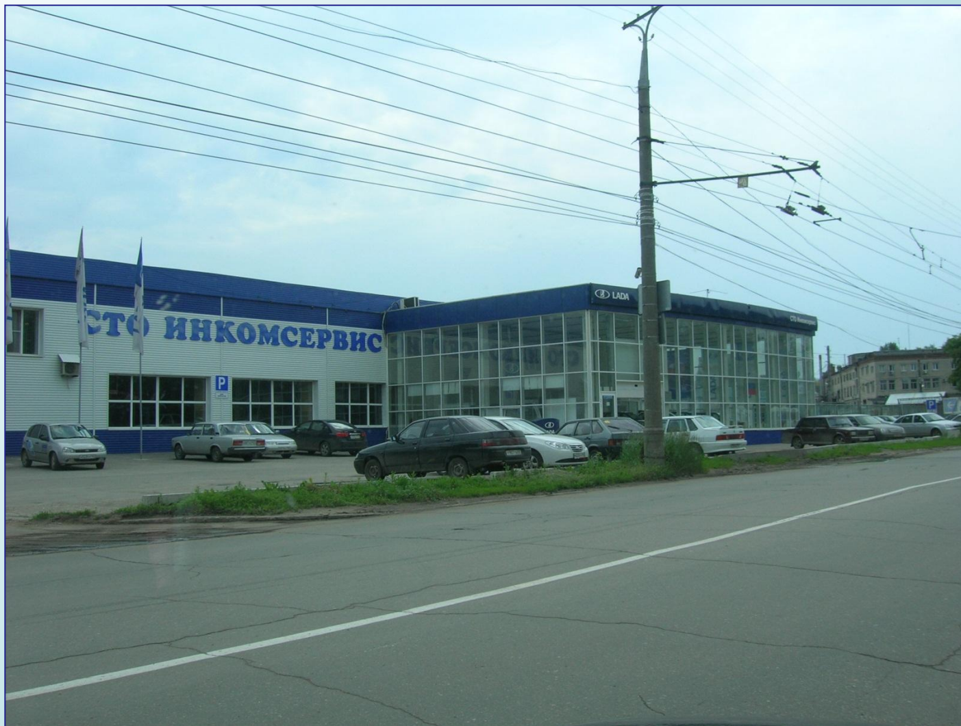
Станция Технического Обслуживания в г.Тольятти на ул. Новозаводская, д.14а
