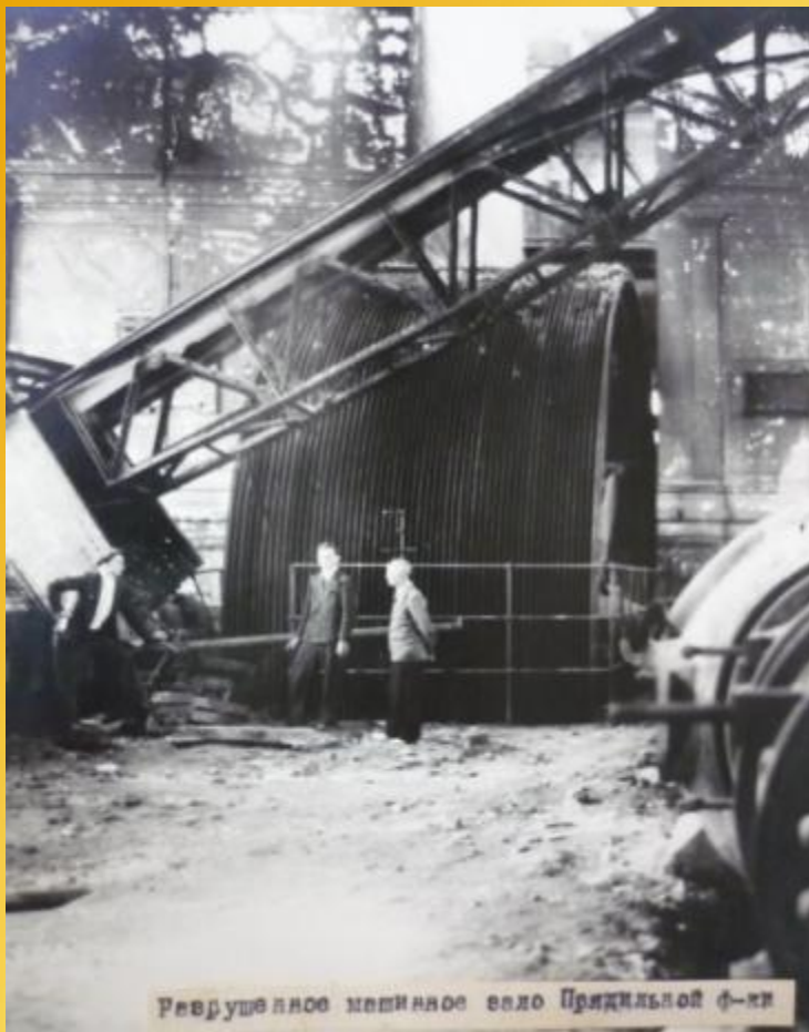
Разрушенное машинное депо Прядильной фабрики.
