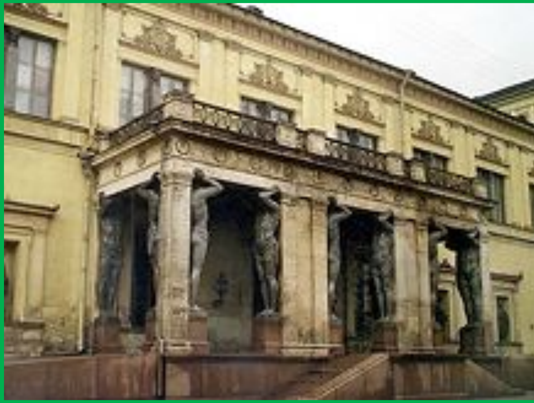
Портик нового Эрмитажа 1839 - 1852 гг. Архитектор Л. Фон Кленце Был открыт для посетителей в 1852г.
