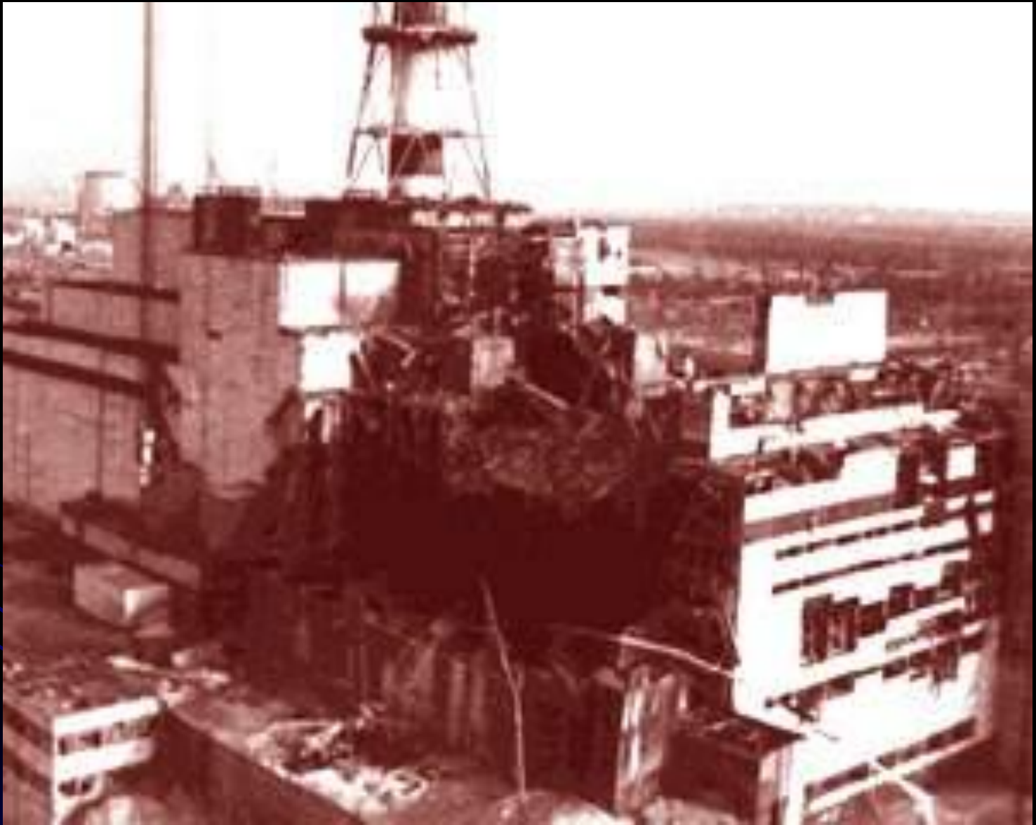
Разрушенный 4ый реактор АЭС
