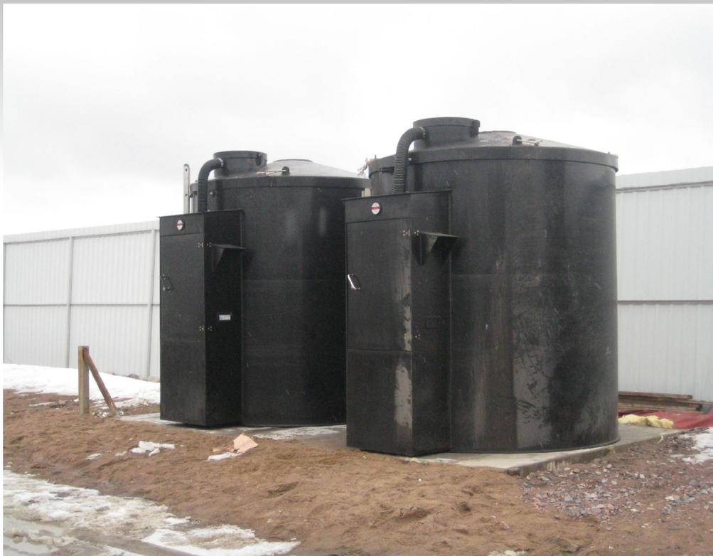
МТМ устанавливается таким образом, чтобы исключить возможность его самопроизвольного сдвига или наклона, которые могут подвергнуть опасности и резервуар, и его оборудование. Рекомендуемая площадка для размещения может быть выполнена из кирпича, бетона, металла и пр. и должна быть ровной, плоской и прочной, что бы выдержать вес заполненного Модуля и обеспечить надежное и долговременное расположения всей конструкции на ней.
