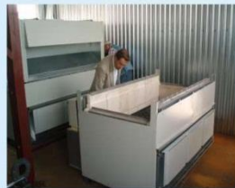
Подготовка к монтажу второго
