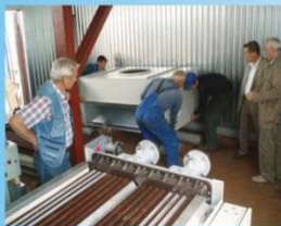
Подготовка к установке тягопре-
