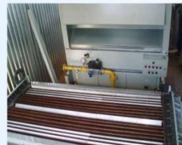
Установлен теплообменник второго
