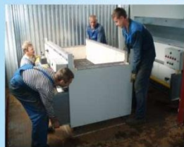
Бригада из 4 человек устанавливает нижнюю часть котла на место монтажа
