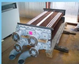
Теплообменники котлов занесены в помещение через обычный дверной проём
