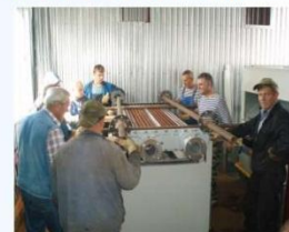
Бригада из 6 человек устанавливает теплообменник в котёл
