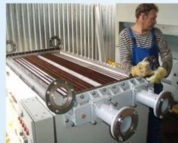
Окончание установки теплообмен-
