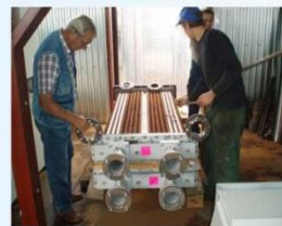
Подготовка основы для установки теплообменника
