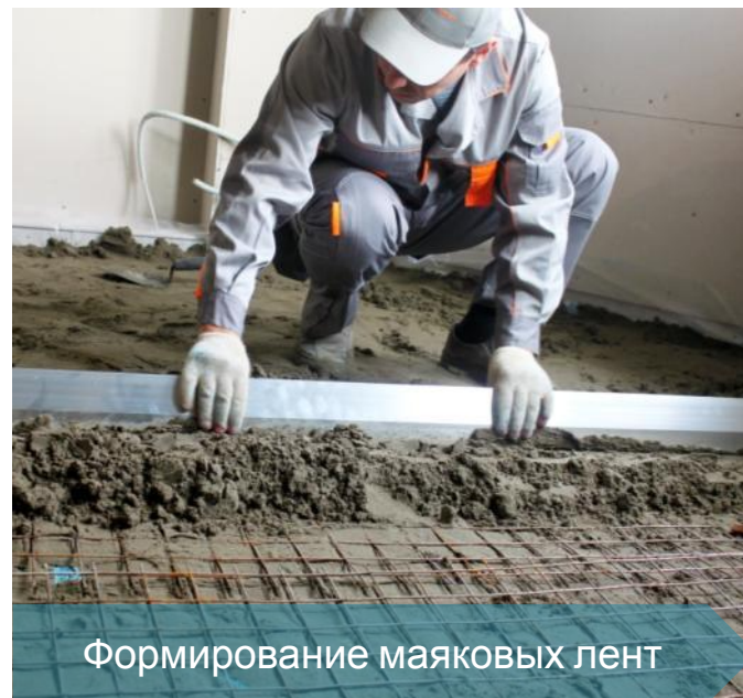
Нанесение пескобетона
