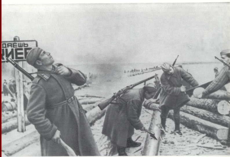
Строительство переправы через Днепр
