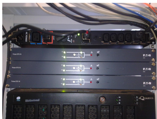
Модуль ручного переключения EATON FLEX PDU и ABP модуль PULSAR STS16
