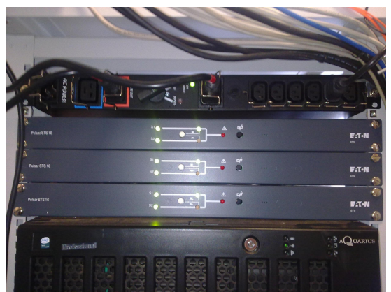
Модуль ручного переключения EATON FLEX PDU и ABP модуль PULSAR STS16
