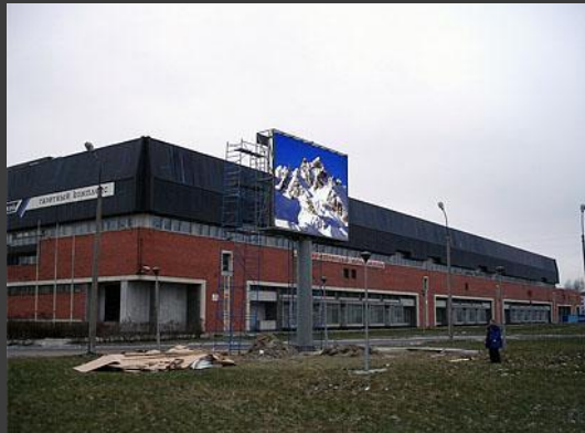
г. Санкт-Петербург, Ленинский проспект, д. 139, ноябрь 2007 г.
