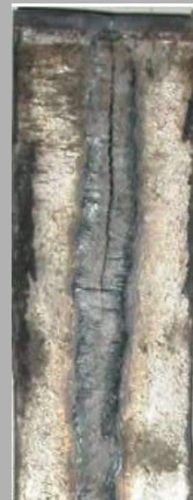
Дефекты сварного соединения
