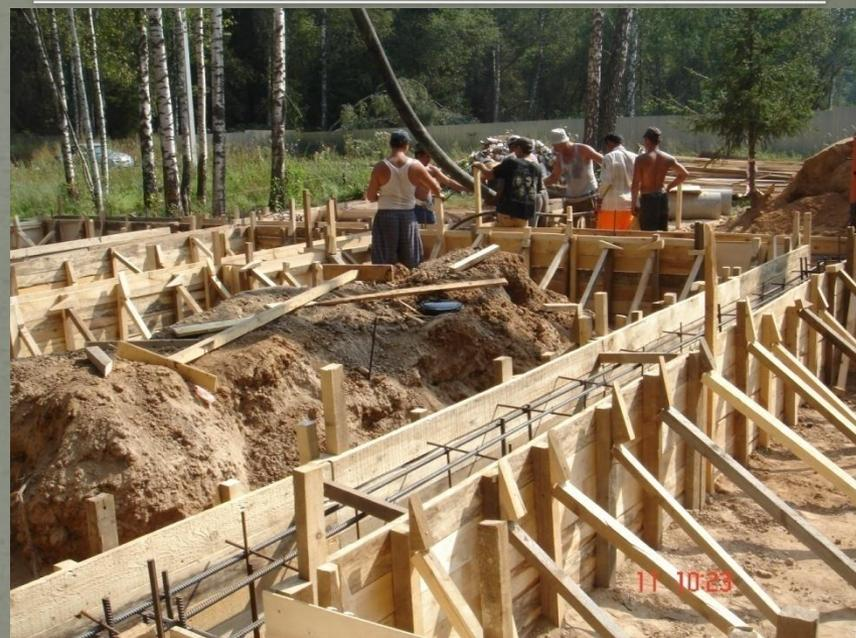
Процесс приемки и отработки 54-х м<sup>3</sup> бетона с учетом параллельной трамбовки электрическими глубинными вибраторами занял 5 рабочих часов. Произведен забор проб (образцов) бетона из 1-го, 5-го и 9-го транспорта. Лаборатория выдала заключение о полном соответствии образцов ТУ и ГОСТу заказанной марки. Вся бригада выразила «особую благодарность поставщику – ООО СК «Остов
