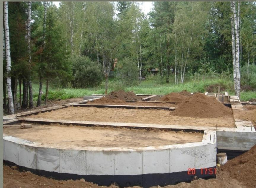
Процесс ухода за бетоном, устройства гидроизоляции, подсыпки и полной обратной засыпки пустот с учетом параллельной трамбовки занял 8 рабочих смен (дней). На 9-й день организованы траншеи для монтажа трассировок сетей энергообеспечения (электрообеспечения, водоснабжения, канализация). Организованы элементы контура заземления для последующего подключения к нему внутренних сетей электрообеспечения и отдельно – громоотвода (заземление крышных конструкций – металлочерепица)
