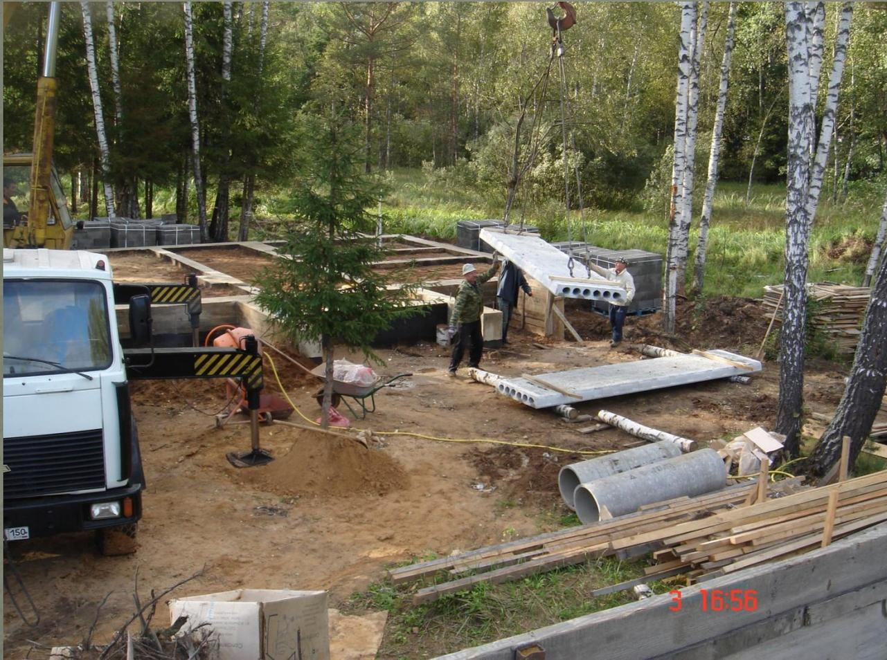
Принят и разгружен первый транспорт стенового материала – керамзитобетонный блок. Сложены для хранения плиты перекрытия 2-го этажа.
