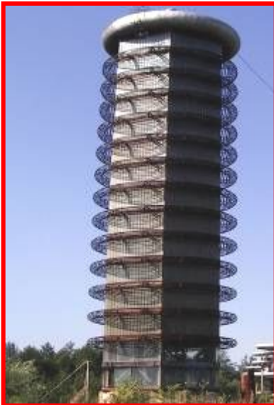
Генератор импульсного напряжения на 10МВ
