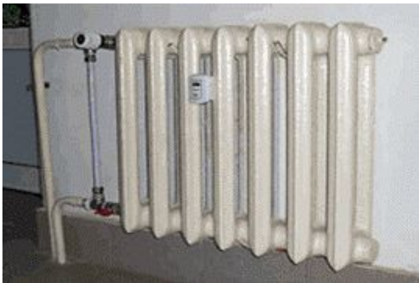
Пример установки распределителя расхода тепла на секционный отопительный прибор
