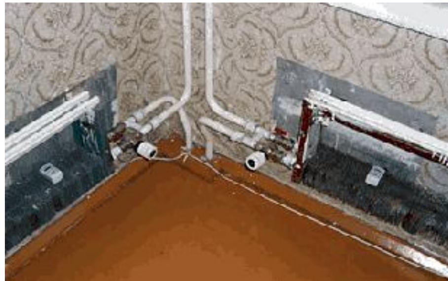
Пример установки распределителя расхода тепла на конвектор
