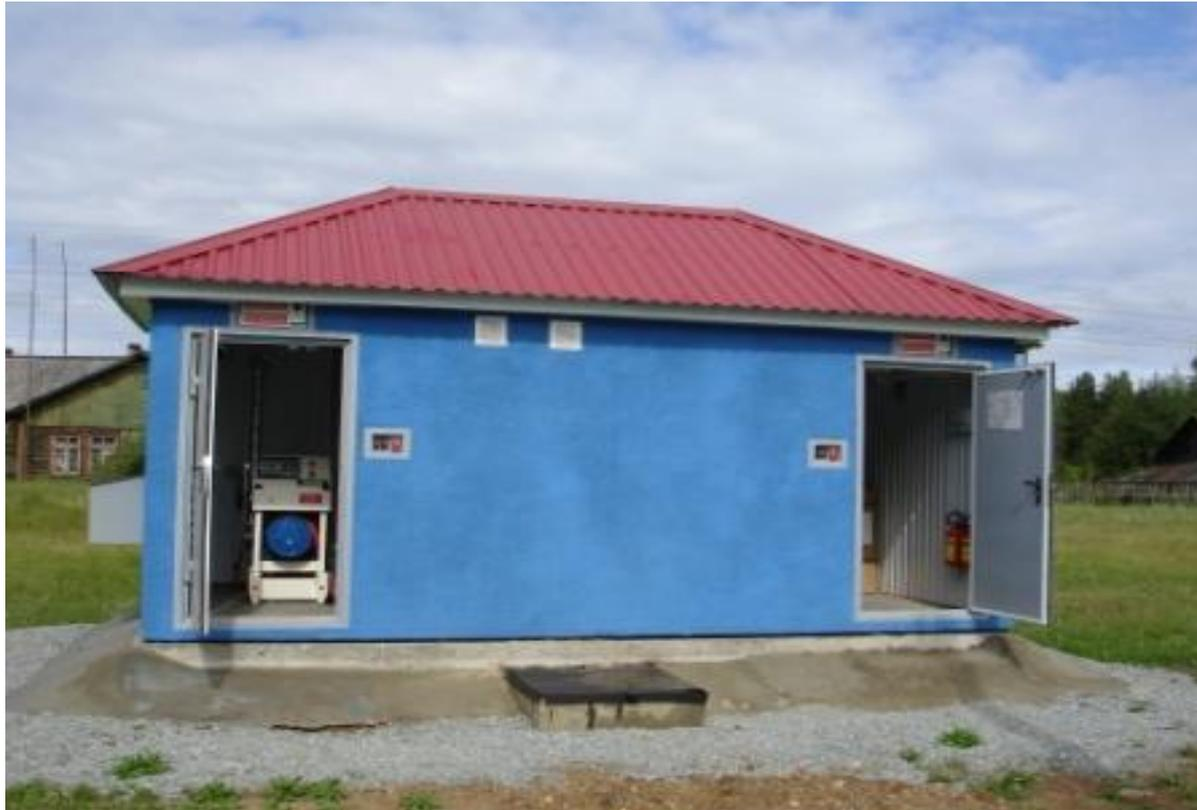
На базе модуля БКАЭС можно быстро организовать на отдаленной станции или в любом другом месте автономное помещение для размещения телекоммуникационного оборудования и оборудования связи технологического назначения.
