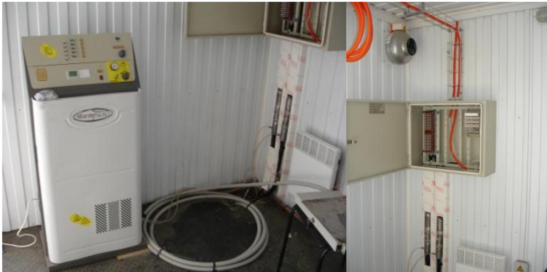
**Для заземления электрооборудования, телекоммуникационного оборудования и оборудования связи предусмотрены 2 шины заземления (для электрооборудования – глухозаземленная, для телекоммуникационного оборудования и оборудования связи изолированная).**
