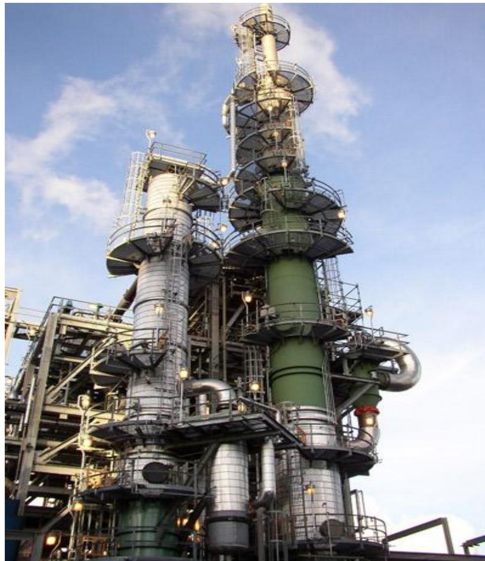
Установка концентрирования диоксида серы на медеплавильном заводе в г.Легница (Польша)
