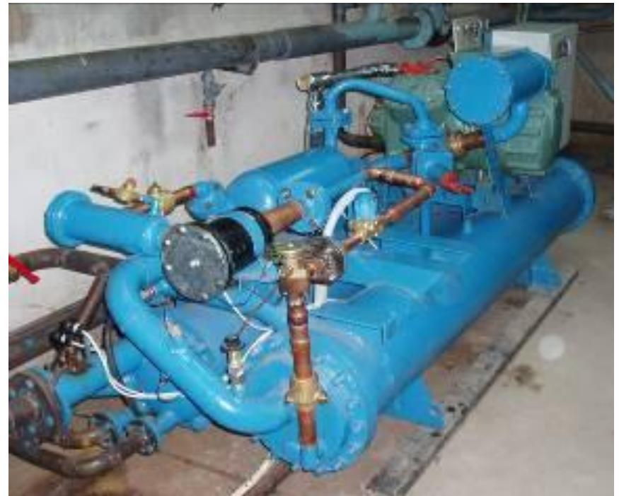
Парокомпрессионный тепловой насос НТ60-1 в схеме отопления Байкальского музея ИНЦ СО РАН (ИТ СО РАН, ВТК «Икар»)
