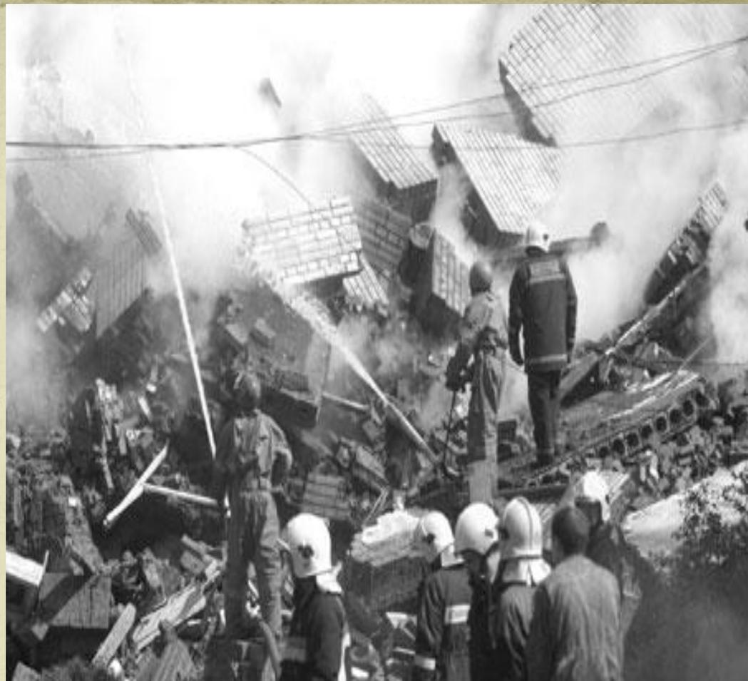
Когда-то засыпанная речка вынуждена была уйти вглубь земли. А сегодня она стала причиной разрушения дома (2002 год). В результате выхода пывуна из-под южной секции четырехсекционного дома по Двинской ул., д. 8 корп. 3, эта секция потеряла опору и отвалилась. В результате обрушения погибло 4 человека.
