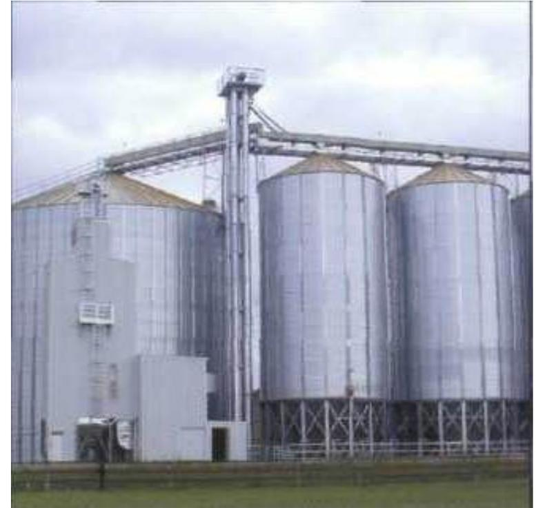
Применение механизированных силосных хранилищ позволит снизить ежегодные затраты труда на погрузочно-разгрузочные работы в 6-7 раз, потери зерна в процессе хранения на 3...5%
