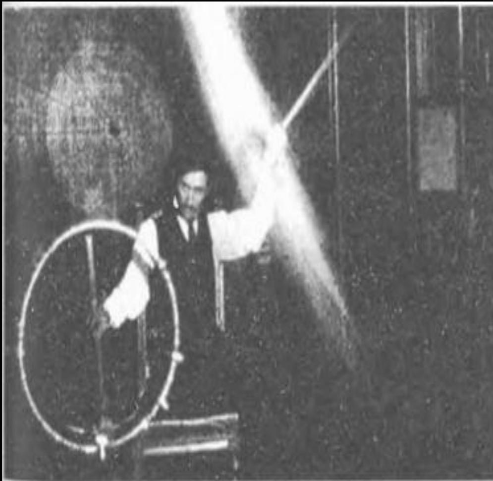
Тесла в своей лаборатории на Хьюстон-стрит пропускает 500 000 вольт сквозь свое тело, чтобы зажечь беспроводную флуоресцентную лампу. 1898 г.
