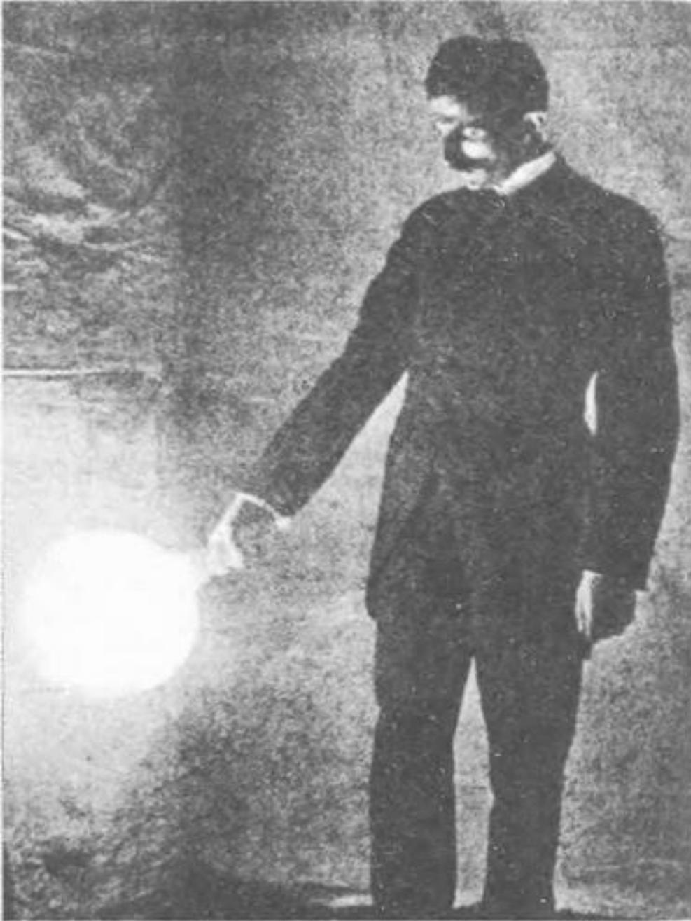
Никола Тесла демонстрирует свою холодную беспроводную лампу без нити накаливания
