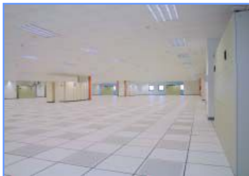
Внутренний вид промышленного здания для высокотехнологичного производства
