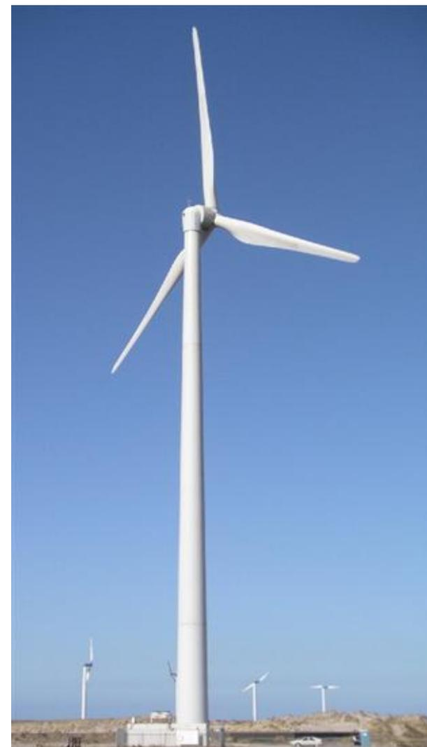
С созданием системы pitch-контроля (управления углом атаки лопастей), разрушающие нагрузки на башню намного снизились (на лопасти и прочие элементы также). Конструкторы ВЭУ создали «Гибкую башню», как более лёгкую и дешёвую.
